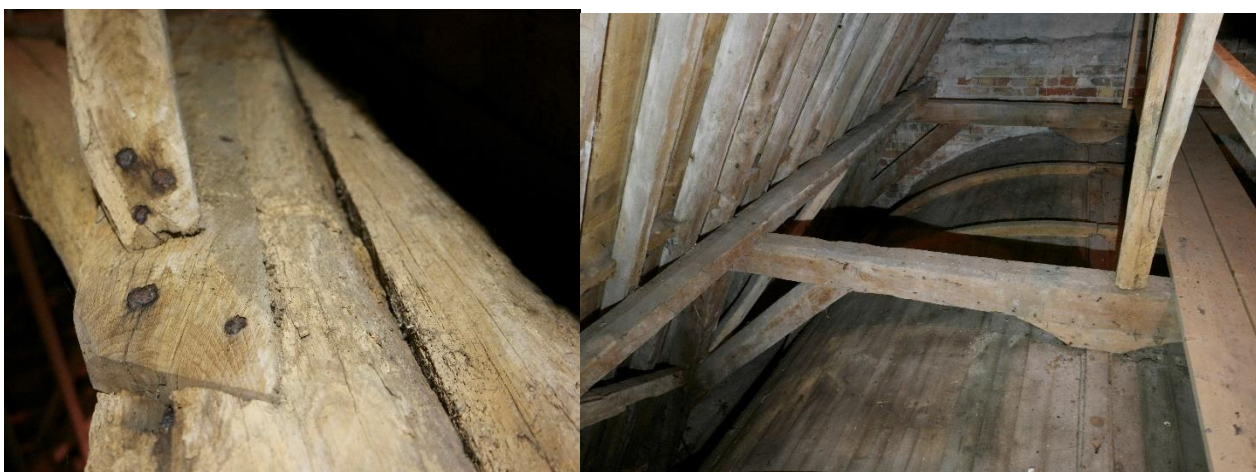
Foto links. Hergebruikte eiken stijl met aanpassingen. Foto rechts. Het vrij zwevende tongwelf wordt gedragen door het schaargebint. Op de dekbalken staat een rij standvinken die op hun beurt de hanebalkfliegering en de hanebalkendragen.
