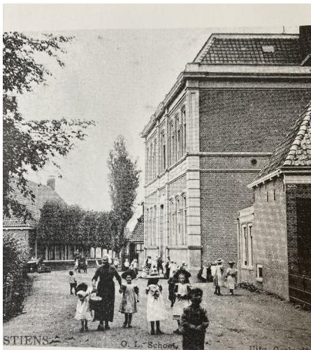
Afbeelding: Zicht op Openbaar Schoolgebouw aan Schoolstraat Stiens
